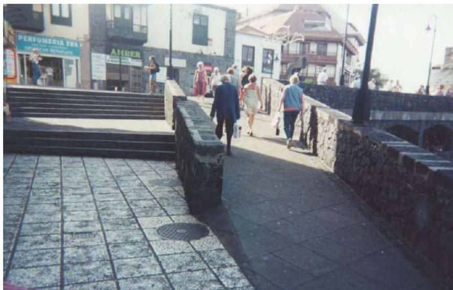
Las soluciones o diseños *universales*, como la rampa de la foto<sup>9</sup>, tomada en Puerto de la Cruz (Tenerife) permiten no estigmatizar a las personas con discapacidad, pues son soluciones aptas para todo tipo de personas, *incluyendo* aquellas con discapacidad. Una rampa bien diseñada e integrada en su entorno puede ser una solución óptima para todo tipo de personas, pues puede ser más práctica y cómoda para cualquiera que las escaleras.
